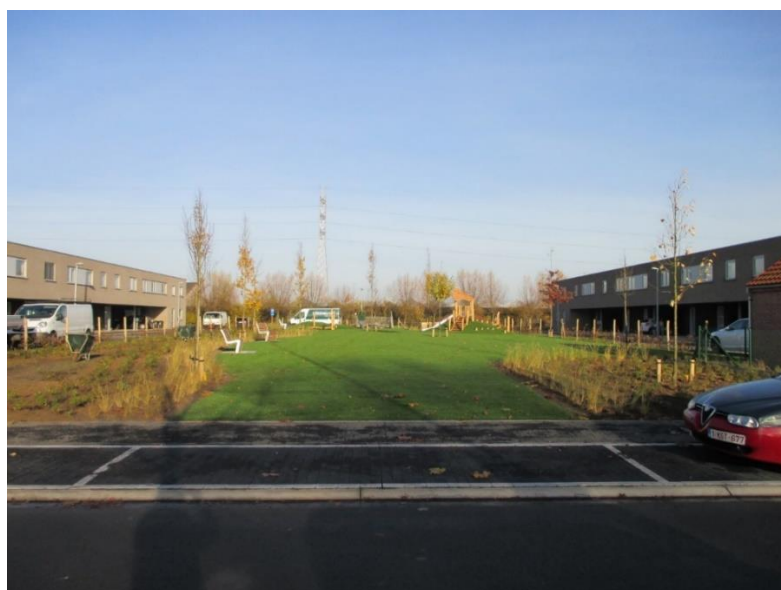
Foto van de werken in Driesknoklaan (Meerkoetstraat) te Deerlijk nadat de omgevingsaanleg was gefinaliseerd.
