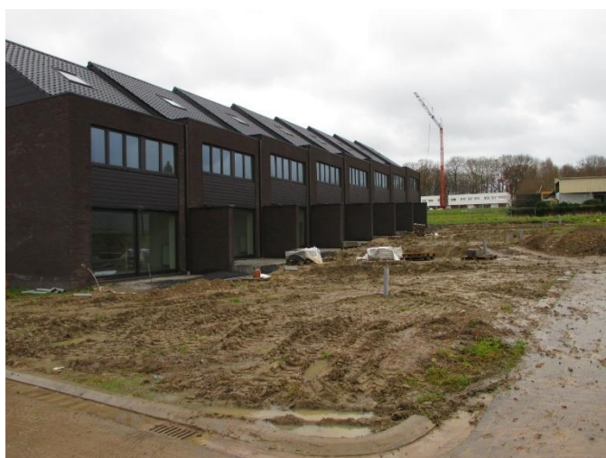
Foto van de werken (blok A1 = 8 rijwoningen) in Ter Schabbe te Anzegem net voor de kerstvakantie 2018.
