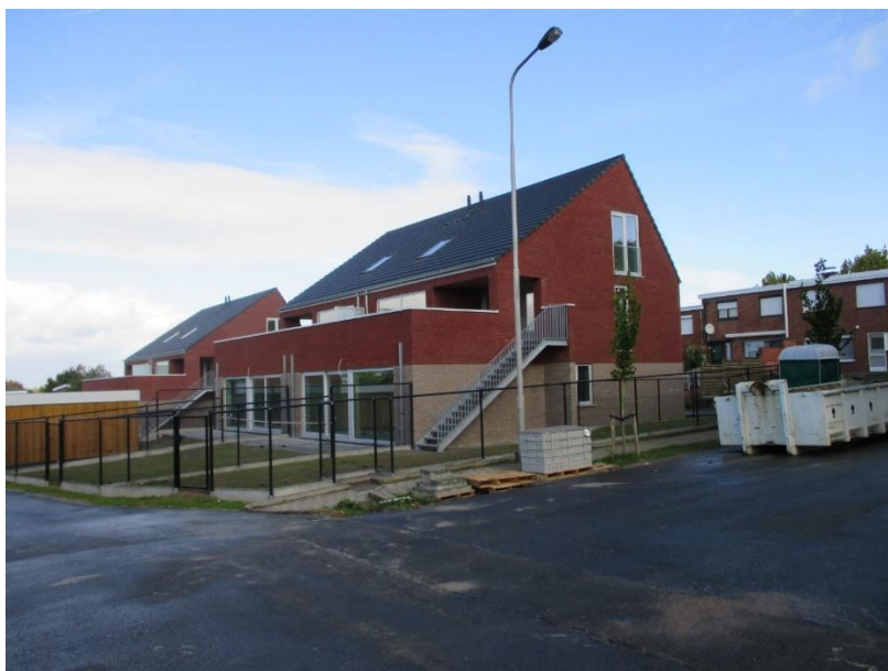
Foto van het afgewerkte project in de Verhammelaan te Sint Lodewijk Deerlijk.
