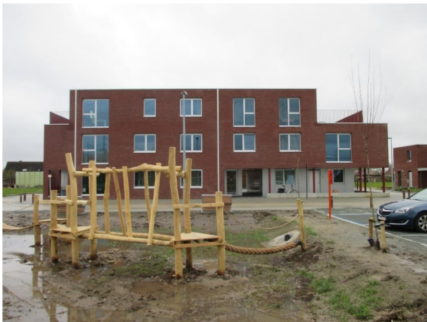
Foto van de werken in de Paanderstraat (De Snepe) te Deerlijk net na het einde van de infrastructuurwerken.
