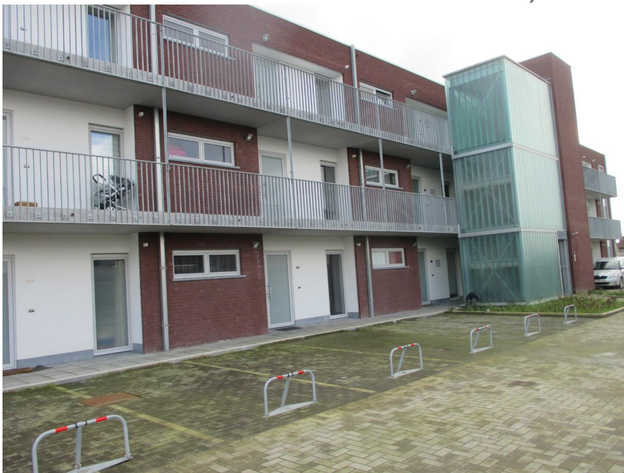
Foto van het project in de Palingstraat te Oostrozebeke – achterzijde van het appartementsgebouw met de algemene trappenhal in Reglit-beglazing.
