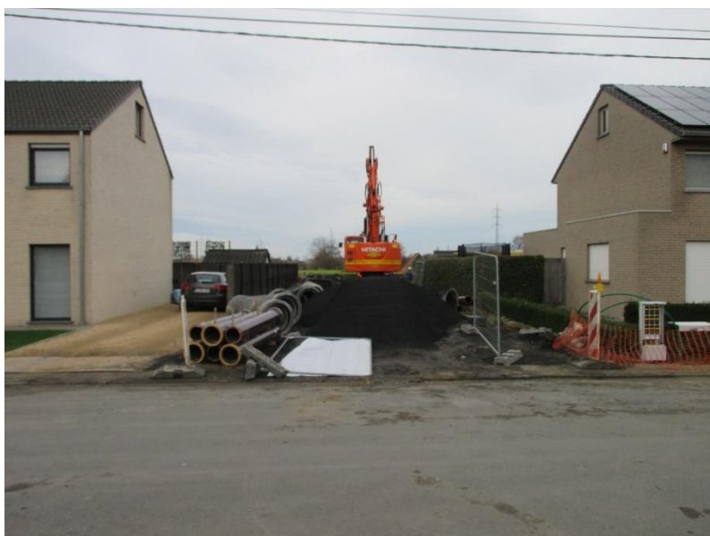
Foto van de infrastructuurwerken in de Vierkeerstraat te Bavikhove net voor de kerstvakantie 2018.
