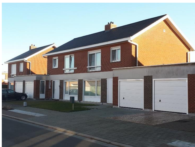
dakrenovatie Oostrozebeke, Halewijnstraat
