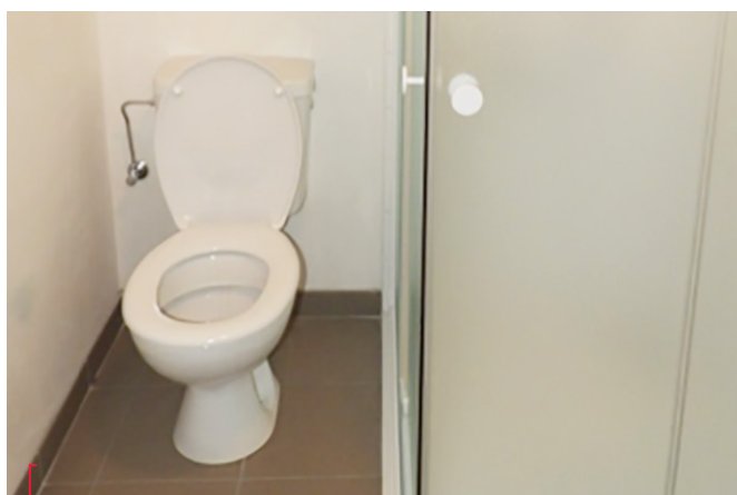
Badkamer na renovatie
