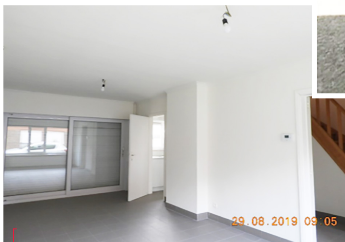
Leefruimte na renovatie
