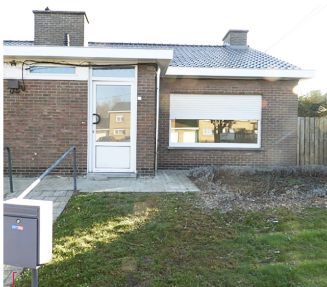
Dakrenovatie Tiegem, Heinsberg
