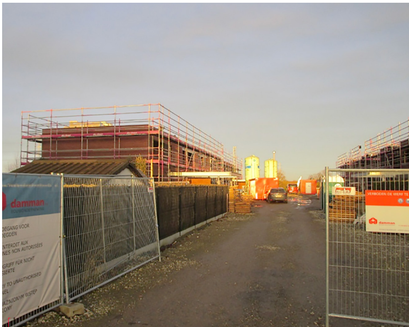
Foto van de infrastructuurwerken in de Vierkeerstraat te Bavikhove eind december 2019.
