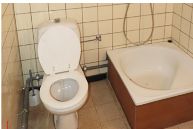
Badkamer vóór renovatie
