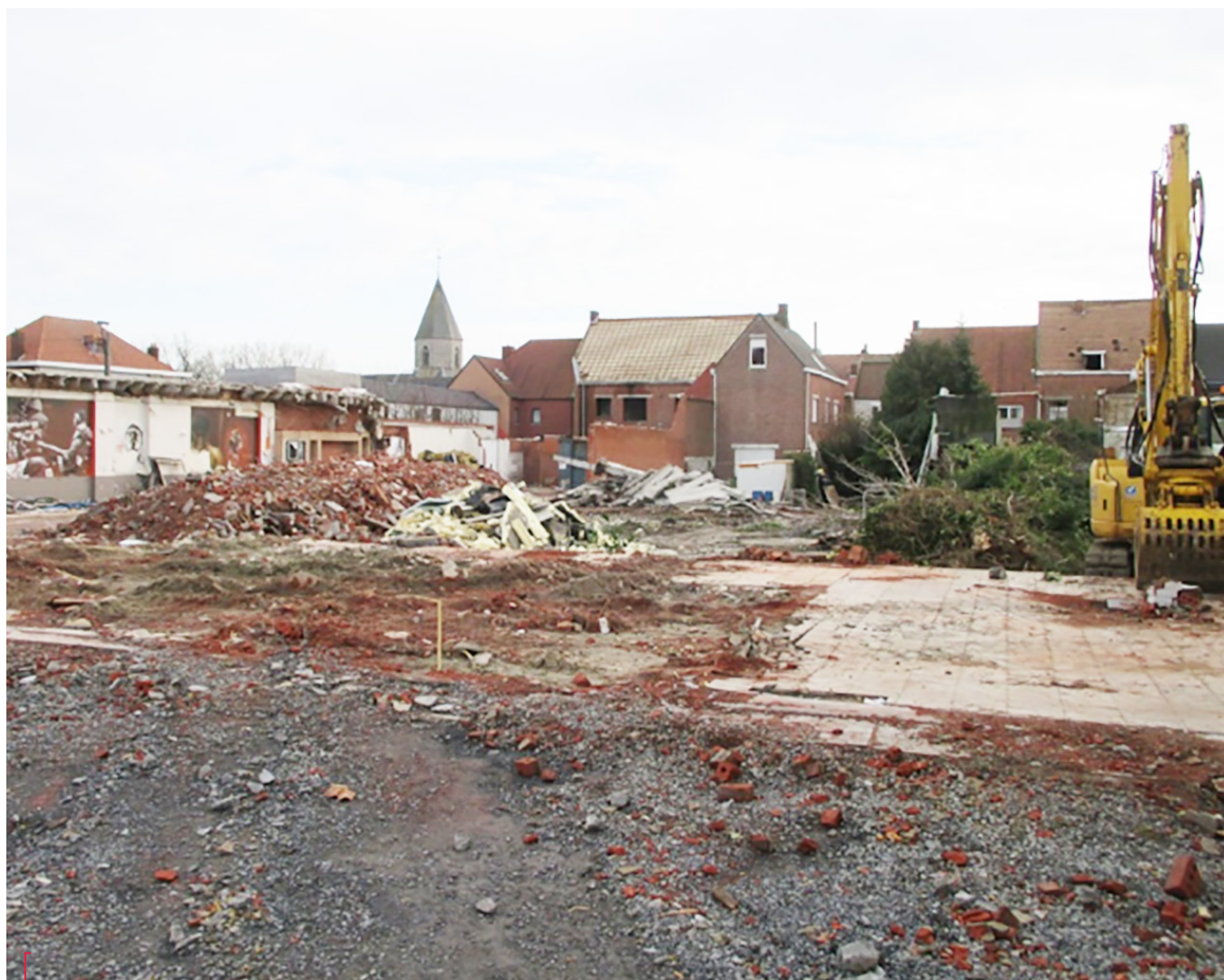
Foto van de afbraakwerken in de Voetweg te Ooigem eind december 2019.
