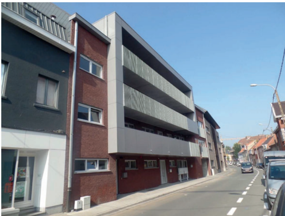
Foto van het project A. Pevernagestraat te Harelbeke kort na de ingebruikname.
