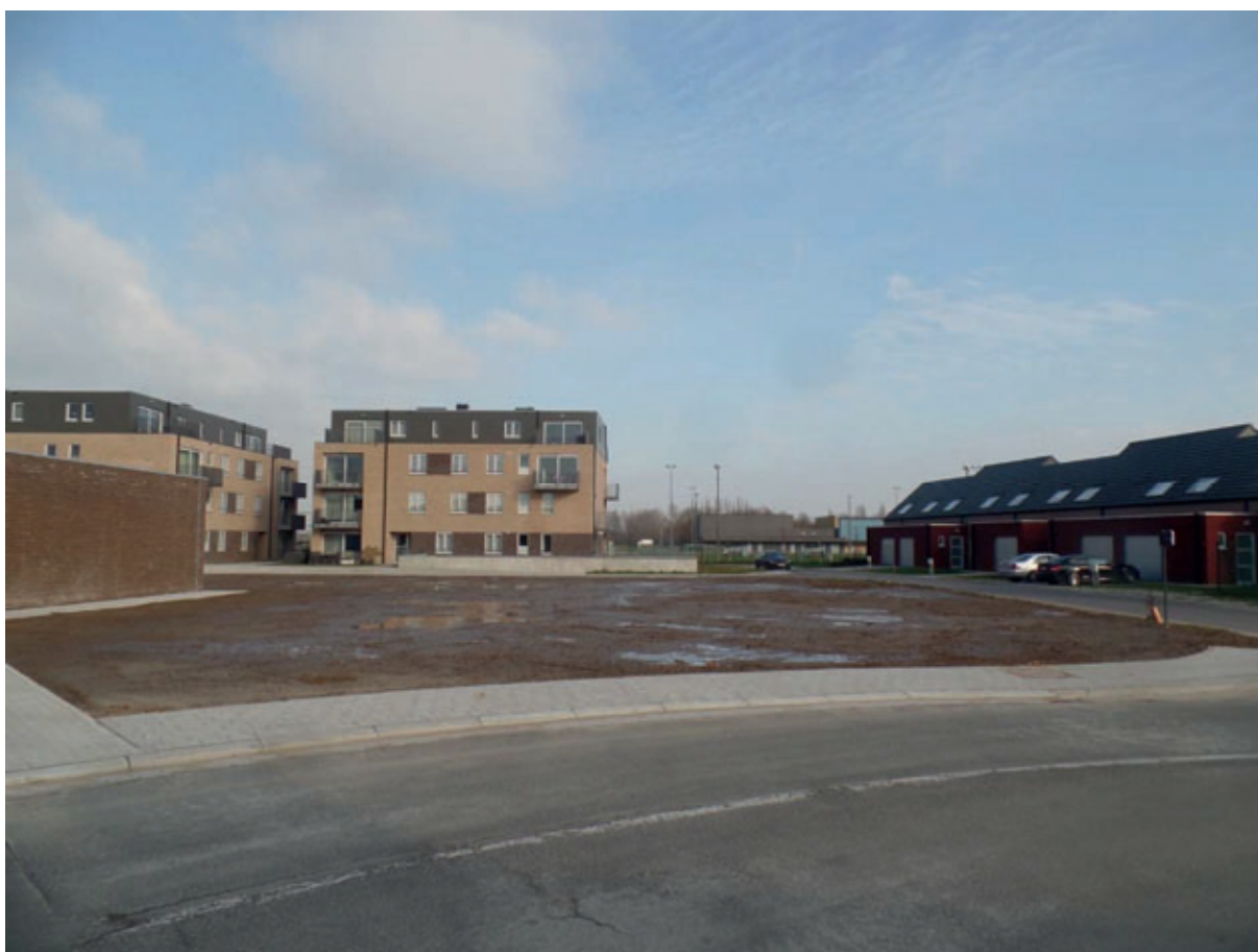
Foto van de werken in Ettingen te Oostrozebeke, genomen op 21/12/2016.
