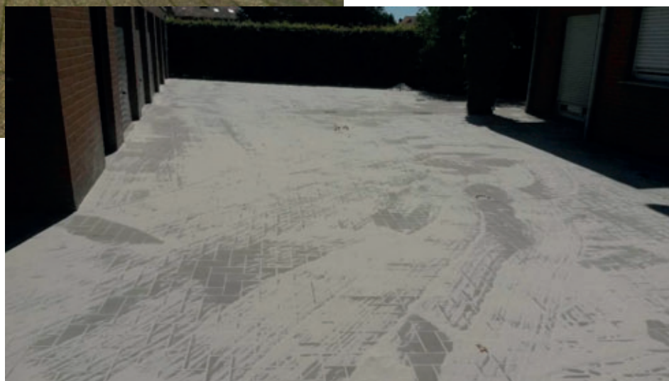
Oprit en parking Domien Veysstraat te Vichte
