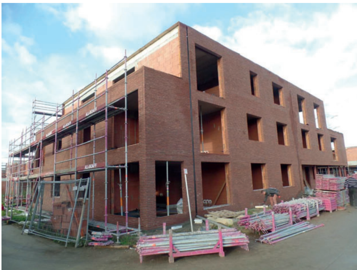
Foto van de werken in de Paanderstraat (De Sneppe) te Deerlijk net voor de kerstvakantie 2017.
