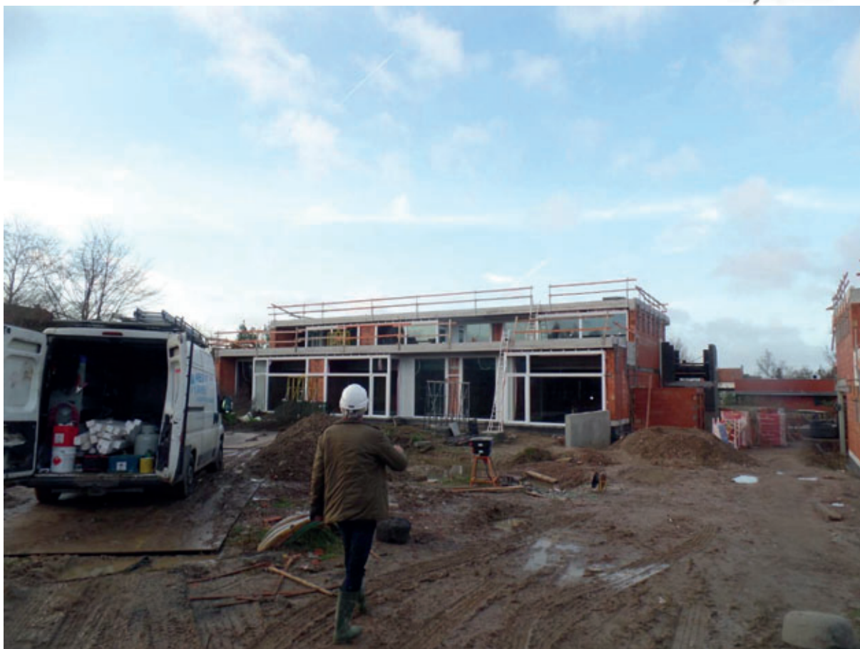
Foto van de werken in Ter Schabbe te Anzegem net voor de kerstvakantie 2017.
