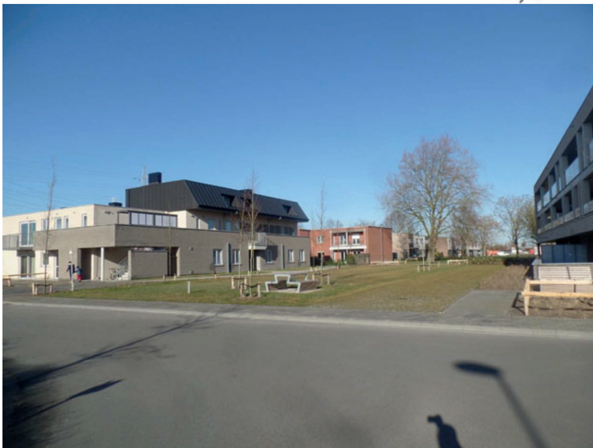
Foto van het project in Boelarestreet te Deerlijk na voltooiing van de infrastructuurwerken.
