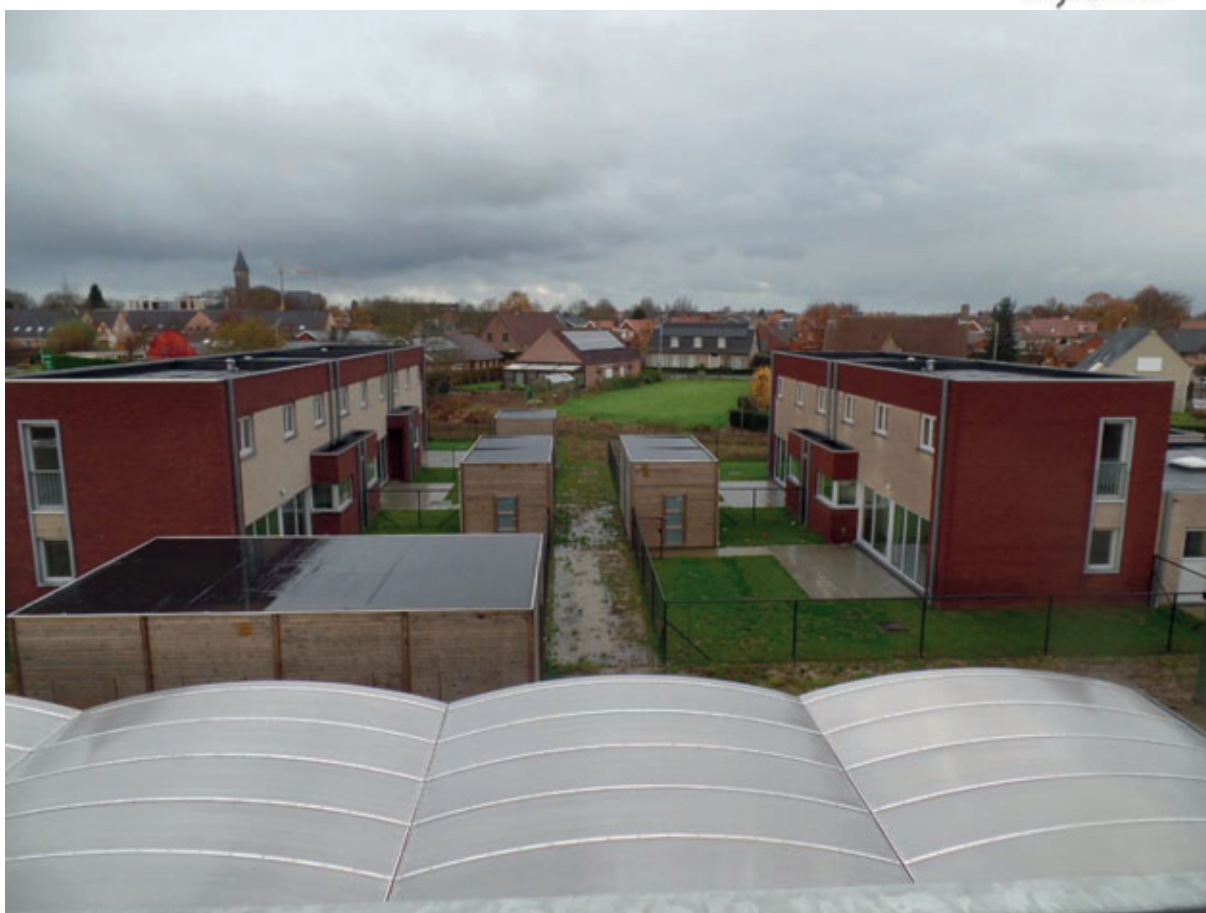
Foto van de bijna voltooide werken in Palingstraat te Oostrozebeke.
