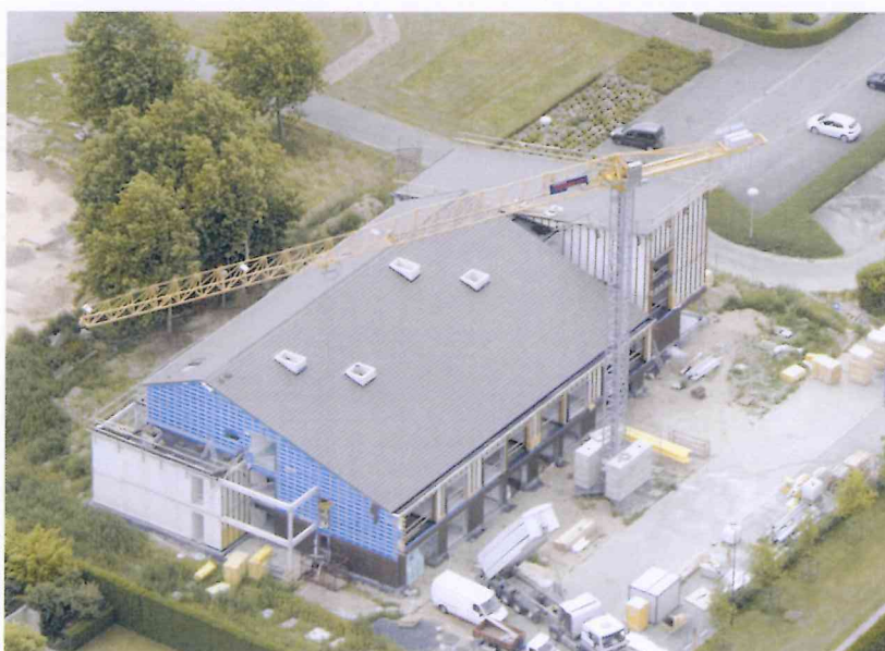
Foto van het project in Lindenlaan genomen op 7 juli 2011.
