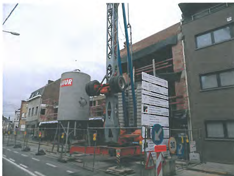
Foto van het project in de A. Pevernagestraat te Harelbeke genomen op 22/12/2014.
