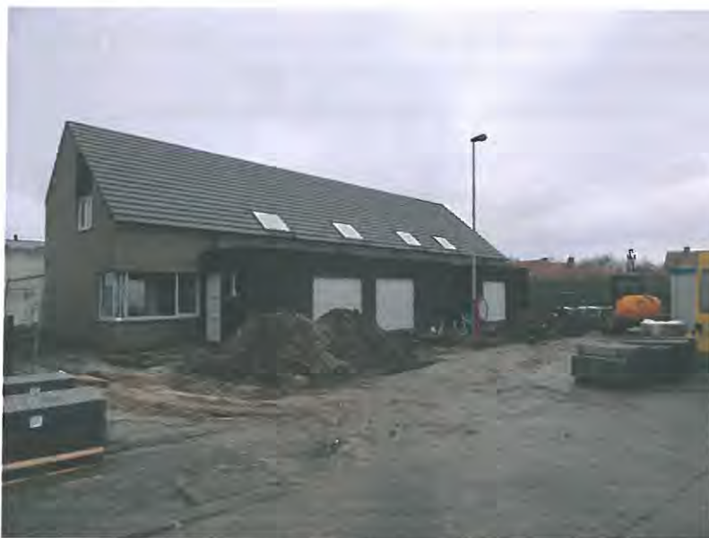
Foto van het project in de Burgemeester Verstaenlaan genomen op 18/12/2014.
