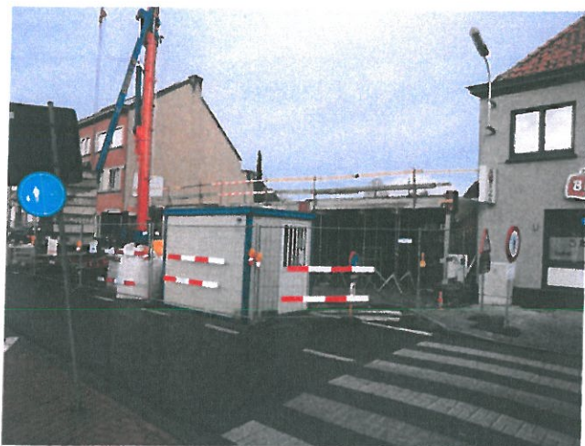
Foto van het project in de Winkelsestraat genomen op 23/12/2013
