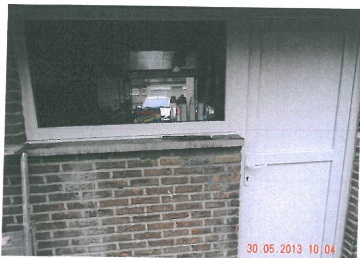
Het vervangen van buitenschrijnwerk in 17 woningen te Hulste.
